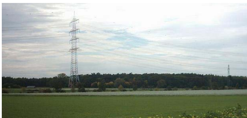
Figura 2.2. Torres y cables de línea de alta tensión del Ejercicio 70.
